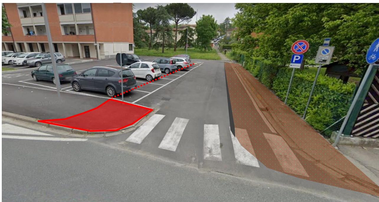
Nell'immagine, a destra la ricostruzione del marciapiede, allargato da 1 a 3,5 metri (si noti l'ottimo allineamento con il percorso ciclo pedonale presente all'interno dell'area verde). In rosso la porzione di marciapiede da demolire.
