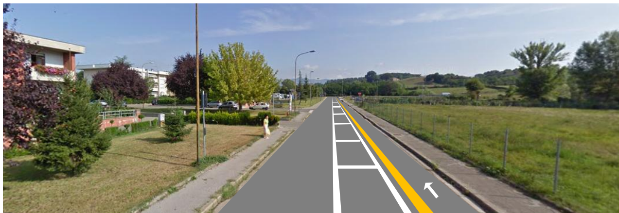
Ricostruzione schematica della sezione stradale: il posteggio in linea viene allontanato di circa 1,8/2,0 metri dal marciapiede per fare spazio alla corsia ciclabile
